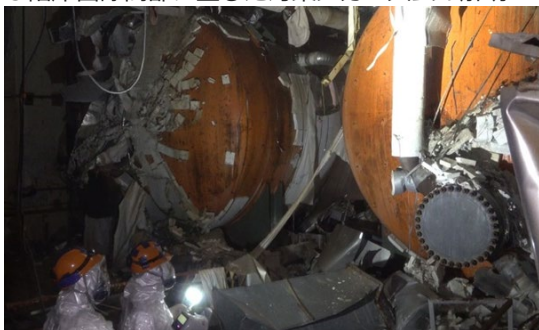
原子力規制庁による原子炉建屋内現地調査
