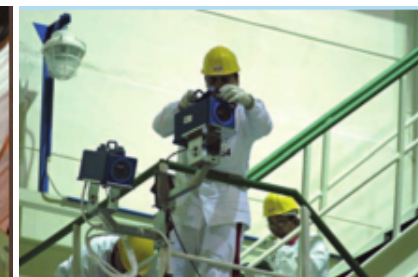
監視装置の保守管理
