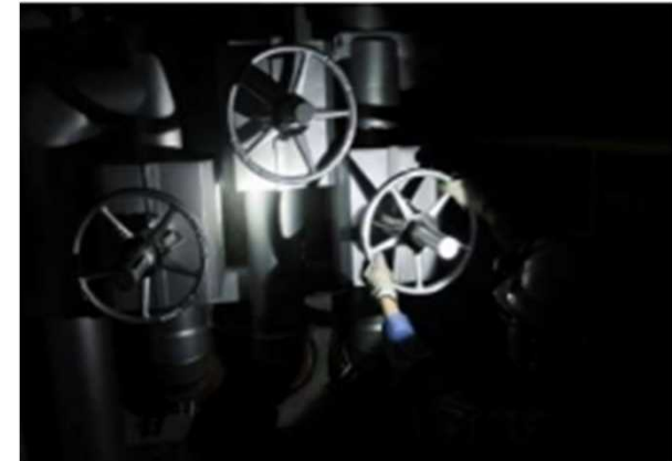
暗所での作業
