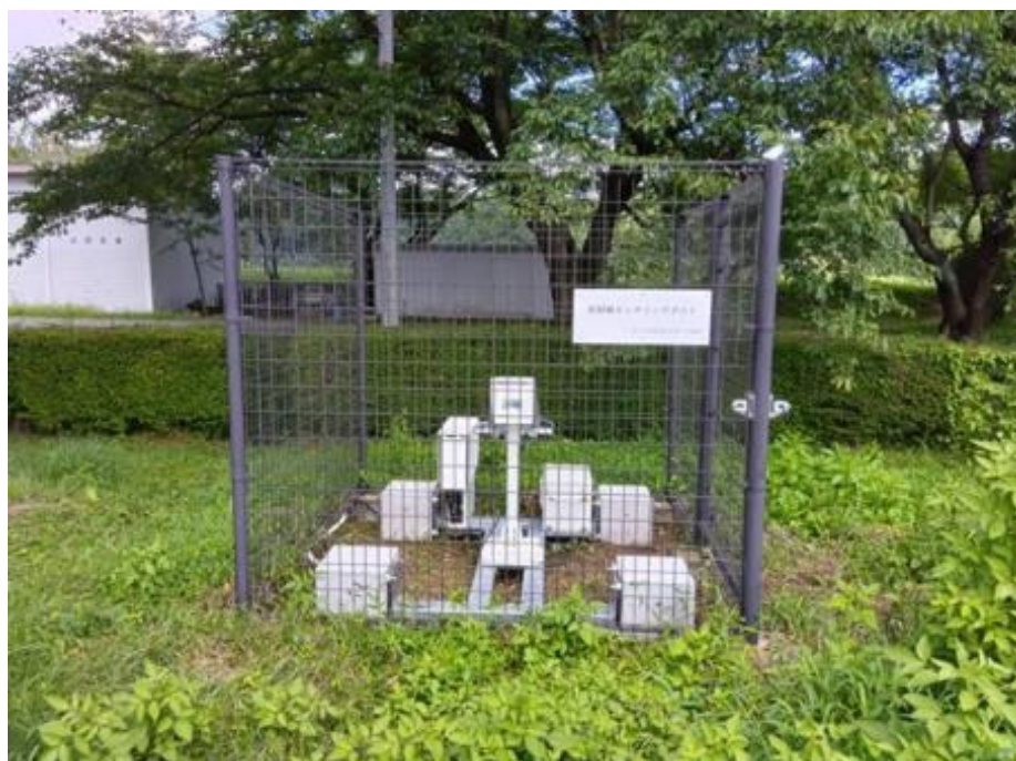
図2-10-8 (1) 撤去前の様子 (白河市総合運動公園 (白河市) : 2024年8月26日撮影)
