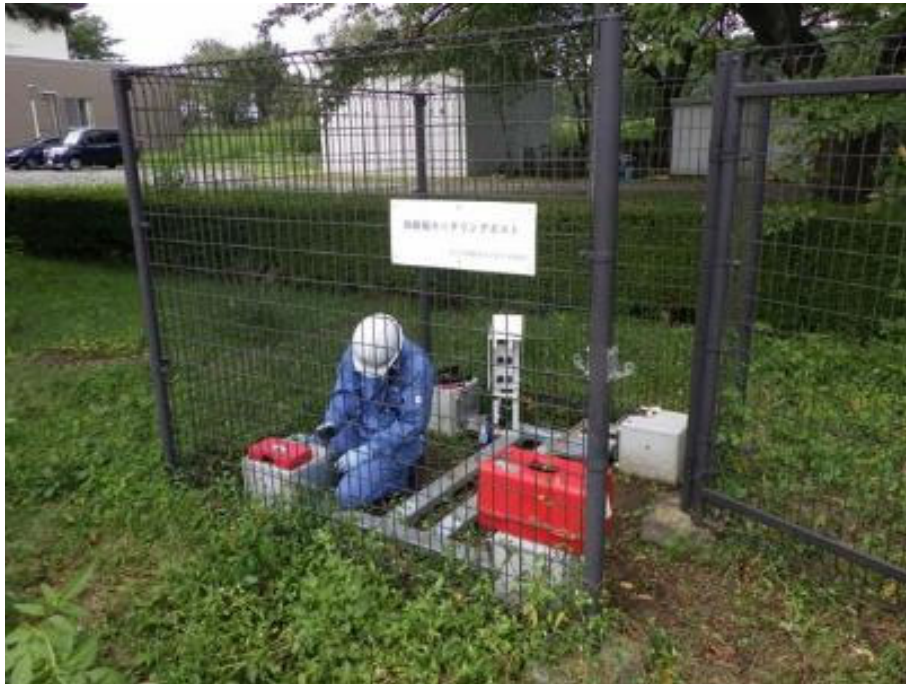
図2-10-8 (2) 撤去作業の様子 (白河市総合運動公園 (白河市) : 2024年9月24日撮影)
