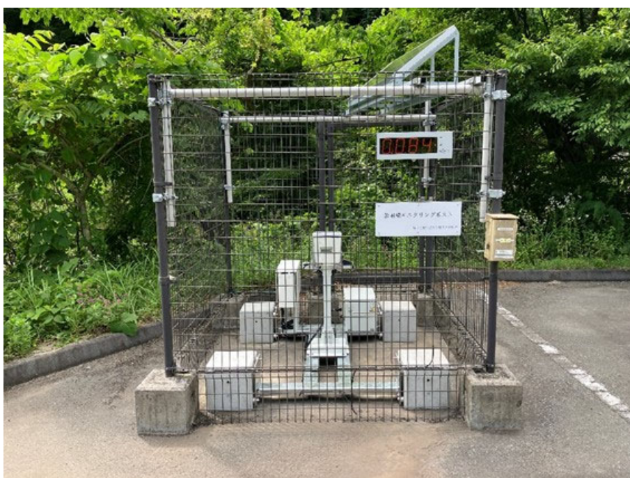
図 2-10-10 (2) 更新後の可搬型モニタリングポスト (五枚沢集会所 (川内村) : 2024 年 6 月 26 日撮影)
