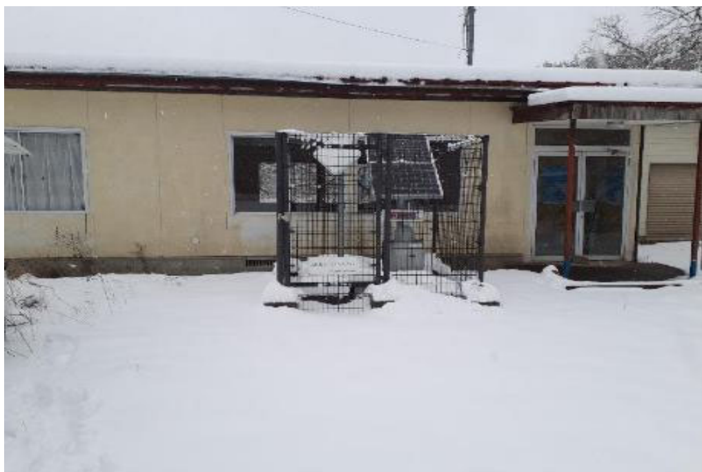
図2-10-5 (2) 降雪の様子 (中屋敷多目的研修集会施設 (大熊町)) 撮影日：2024年3月6日
