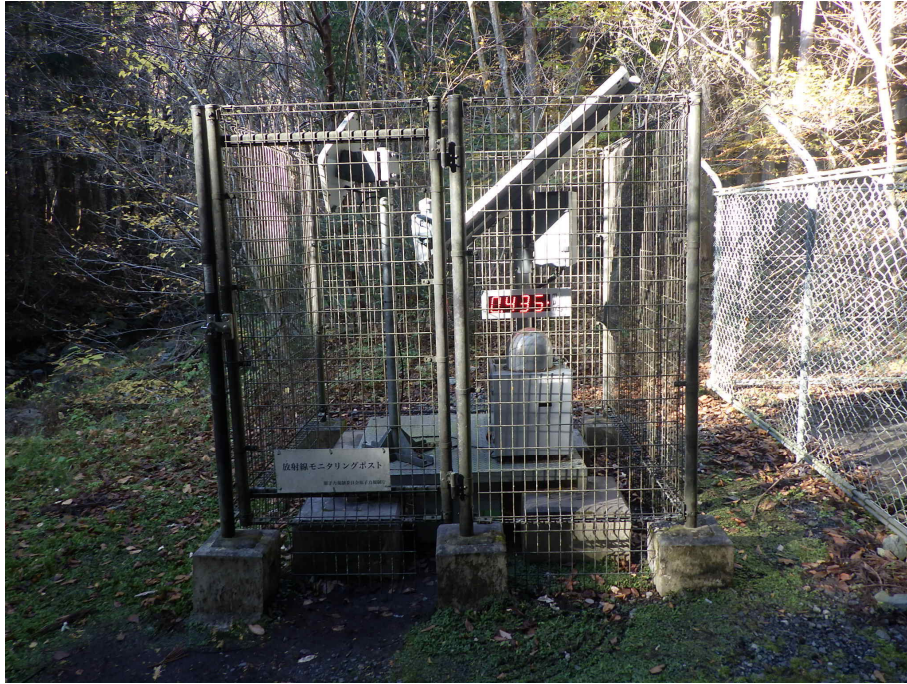
図 2-10-10 (5) 更新前の可搬型モニタリングポスト (高の倉ダム助常観測所 (南相馬市) : 2024 年 11 月 26 日撮影)
