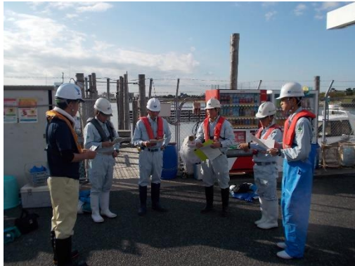
①作業前の TBM（作業前安全確認）
