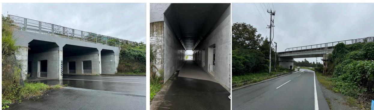
図 31 高速道路と交差する部分の現地調査の様子。大川原再生賃貸住宅付近の交差点（左）は開口部に対して奥行きが長く（中）、導波管のように周波数や入射方向によって通過の際の減衰に大きな違いが現れると予想され、WI-SUN FAN 端末による試験でも開口部との位置関係や開口部からの距離で大きな影響が現れた。一方県道 166 号との交差点は開口部が大きい一方奥行きが短く、実際の Wi-SUN FAN 端末を用いた通信試験でも、交差点が大きな影響を与えることはなかった。
