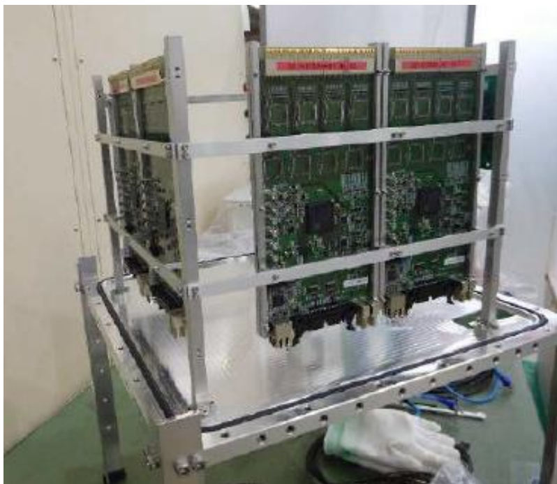
図 A-8 信号中継基板の取付
