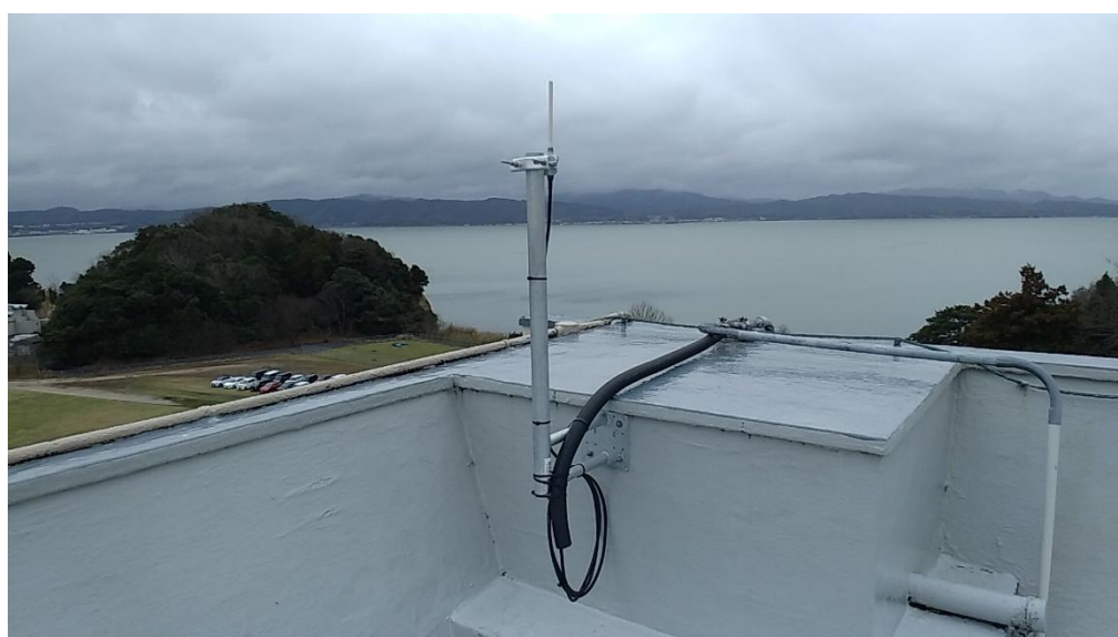
図 3-17 ZETA AP のアンテナの取り付け場所（県保健環境科学研究所）
