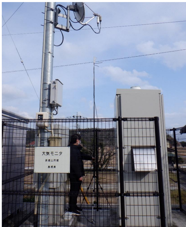
図 5-15 予備機を使った通信試験
