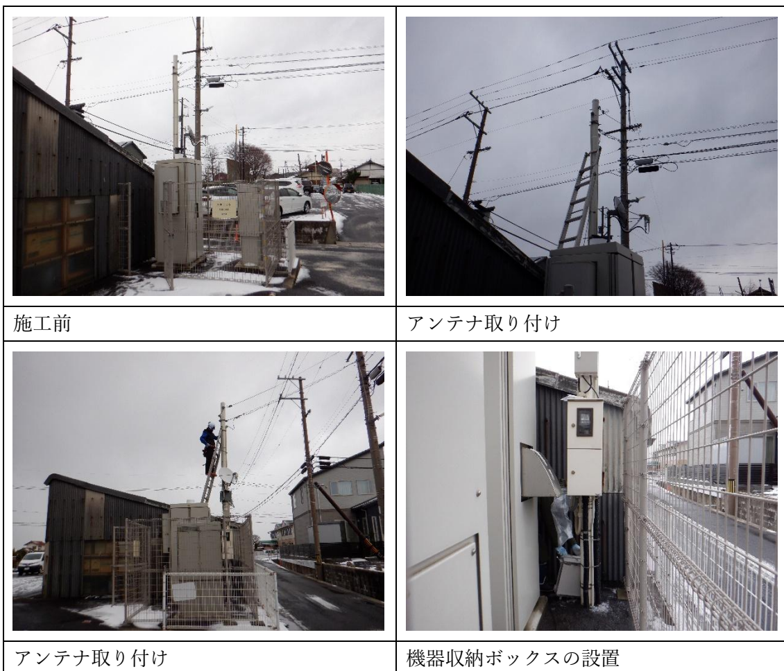
図 5-6 既設モニタリングポスト（玉湯支所）への設置作業①
