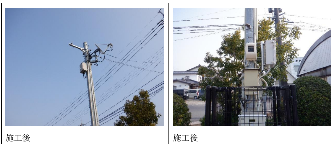
図 5-5 既設モニタリングポスト（くにびきメッセ）への設置作業②
