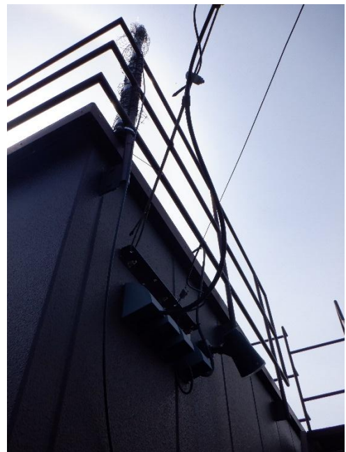
図 3-15 ZETA 通信機器アンテナの設置
