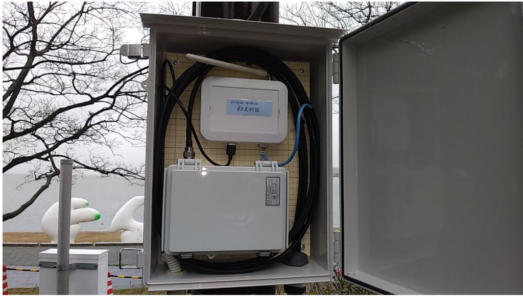
図 3-9 ZETA 通信機器の設置の様子
