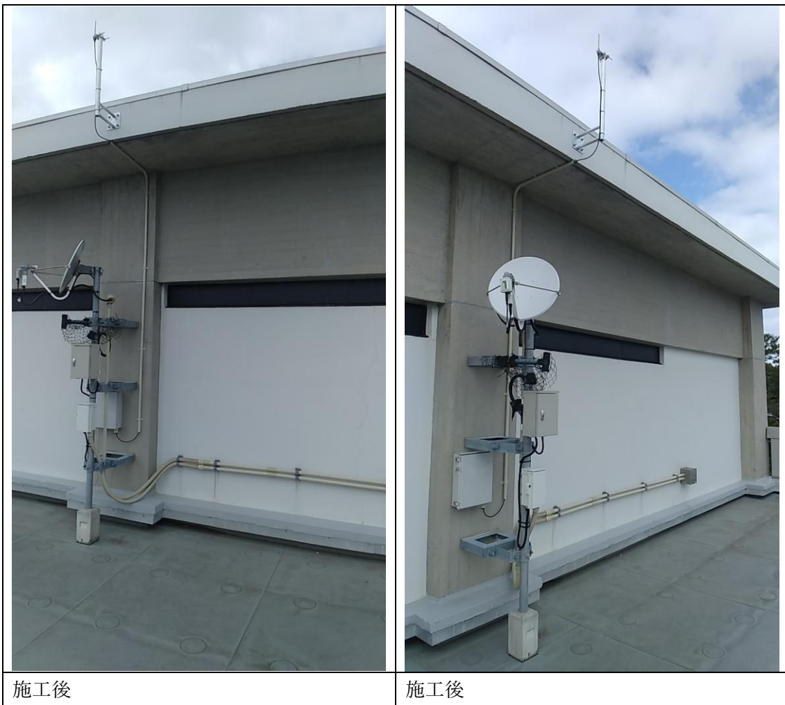
図 5-12 中継器局（県庁）への設置作業②
