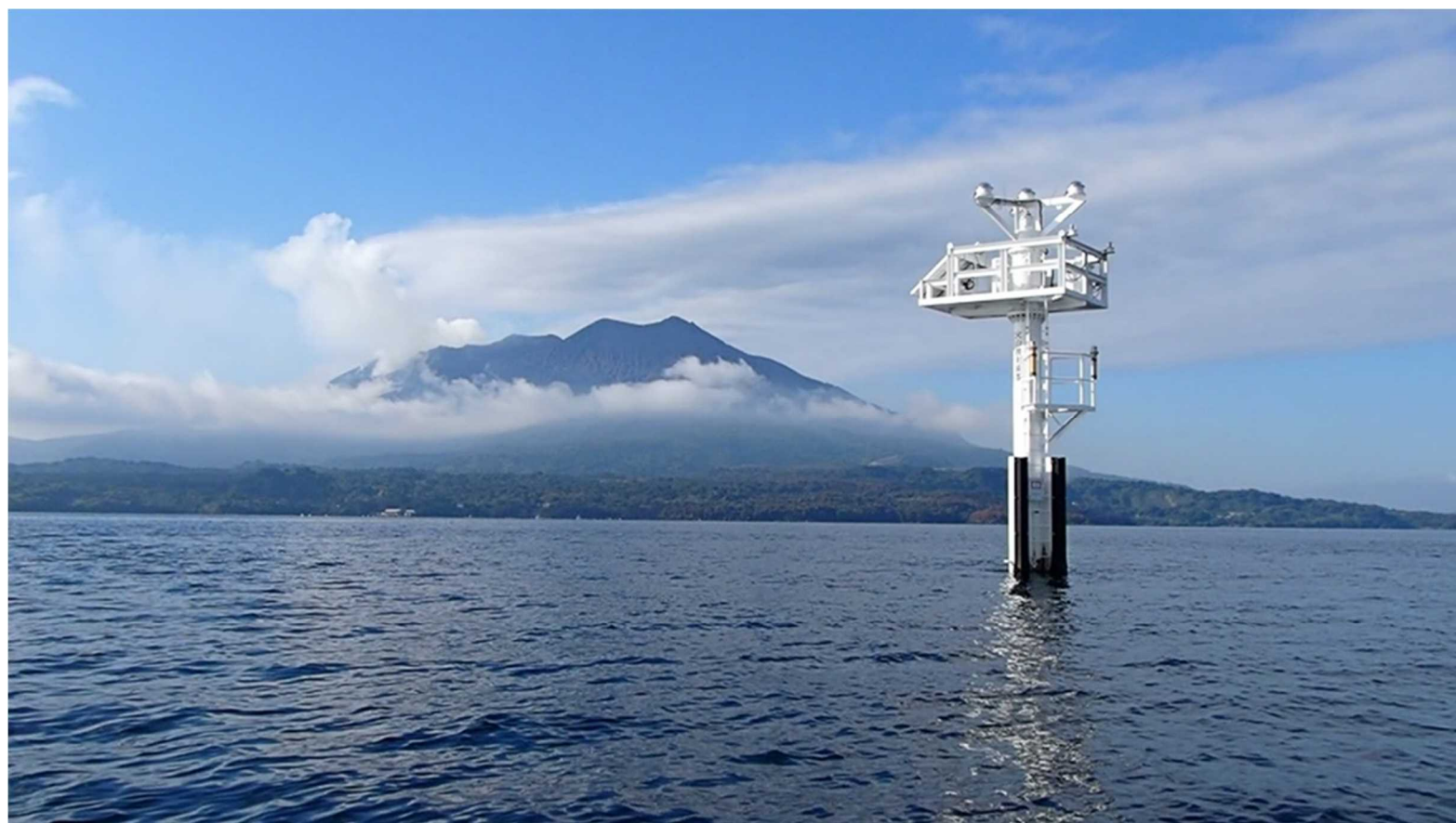
図5 海底地盤変動観測装置
