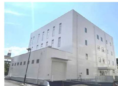
原子力災害医療研修兼除染施設
