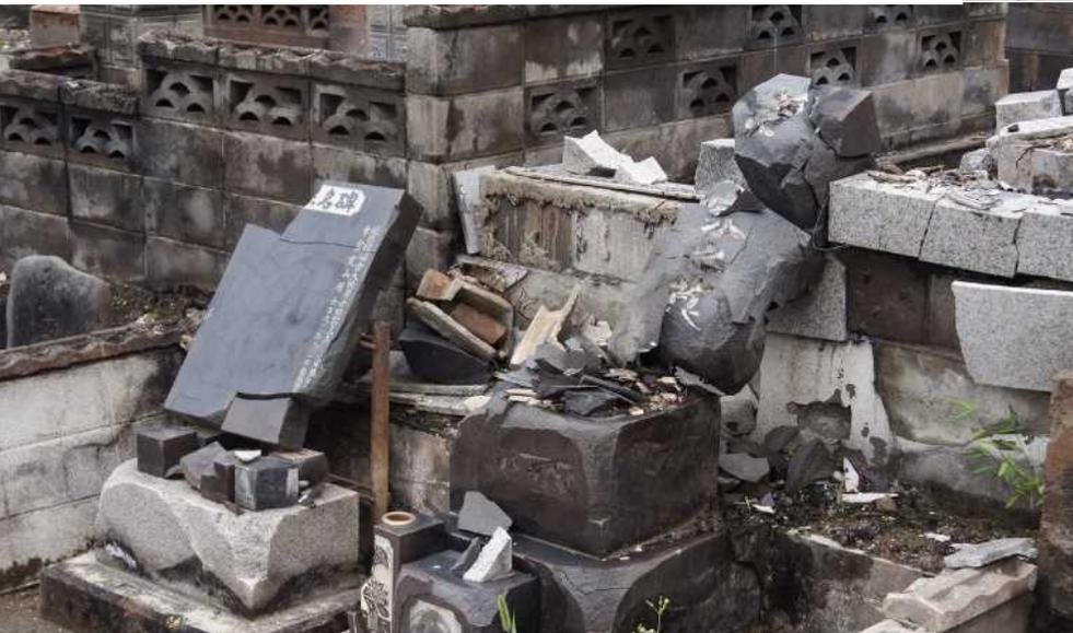
墓石が下流側に倒れ、火災で表面が剥離
