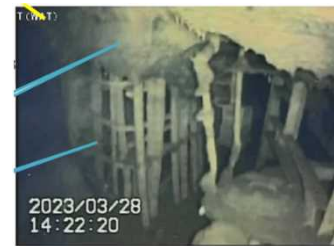
1号機ペDESTAL 開口部付近の状況
