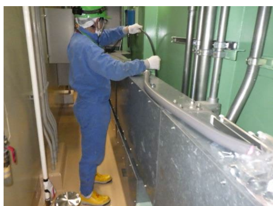
(b) 炉下室~炉室へのケーブル引き込み（左：炉室側、右：炉下室側からみたところ）
