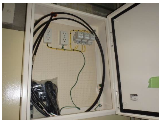
(c) キャビネットボックス取付後の写真（左：炉室、右：炉下室）
