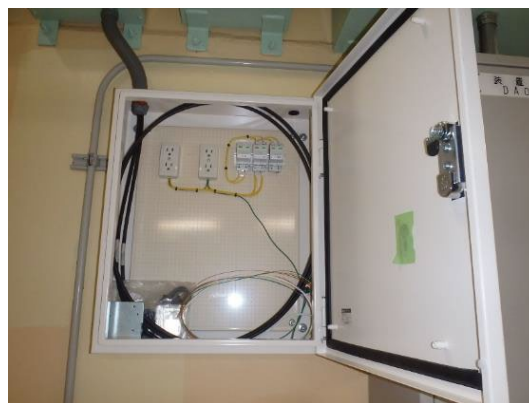
(c) キャビネットボックス取付後の写真（左：炉室、右：炉下室）
