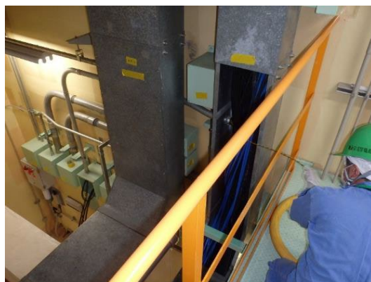
(a) 炉下室へのケーブル引き込み
