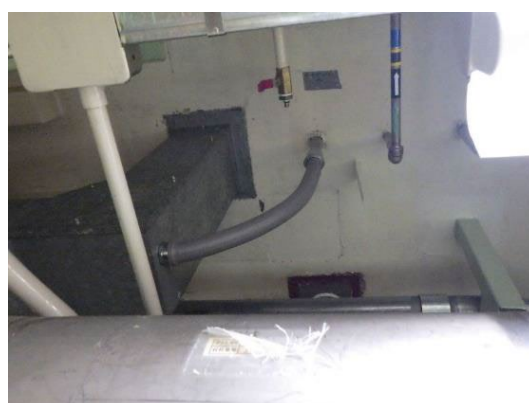
(b) 炉下室~炉室へのケーブル引き込み（左：炉室側、右：炉下室側からみたところ）
