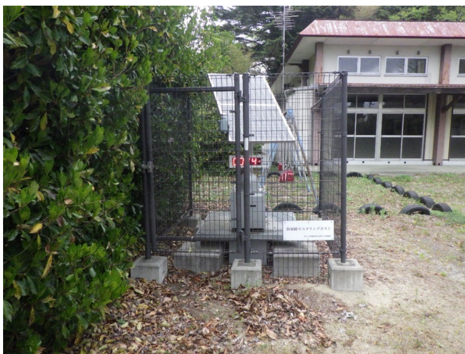
図2-10-10(1) 撤去前の様子 (金房幼稚園(南相馬市)：2023年4月12日撮影)
