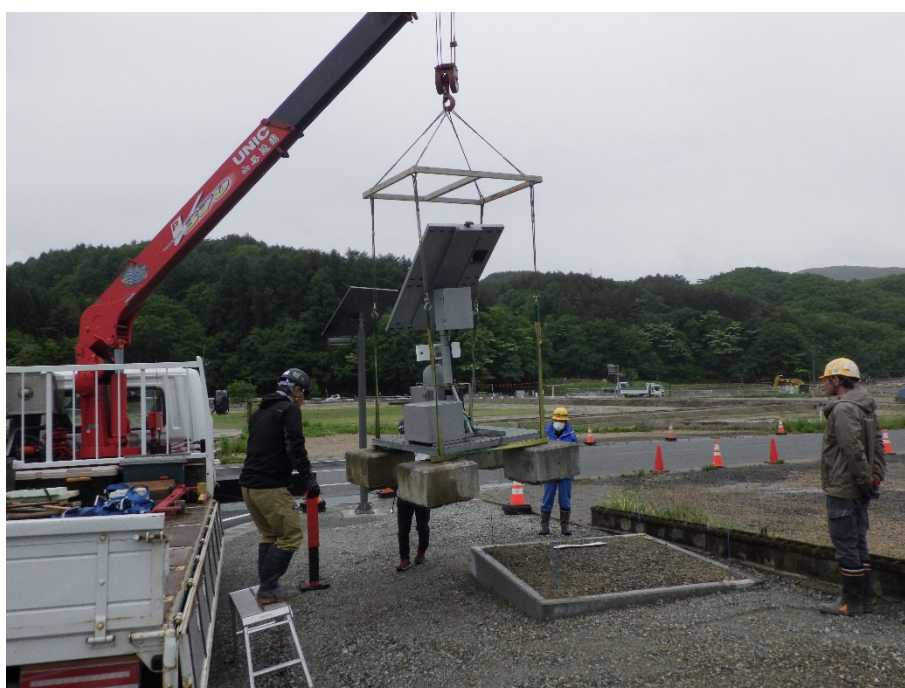
図2-10-13(1) 設置作業の様子 (長泥コミュニティーセンター(飯舘村)：2023年5月23日撮影)
