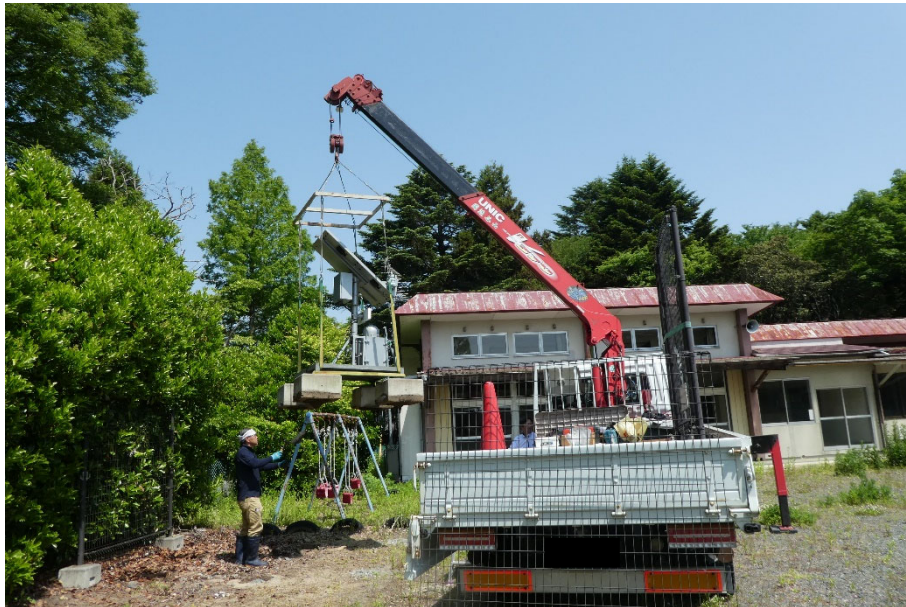
図2-10-10(2) 撤去作業の様子 (金房幼稚園(南相馬市)：2023年5月17日撮影)
