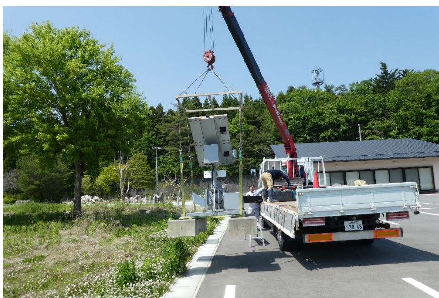
図2-10-12(1) 設置作業の様子 (荏野防災コミュニティセンター(浪江町)：2023年5月17日撮影)
