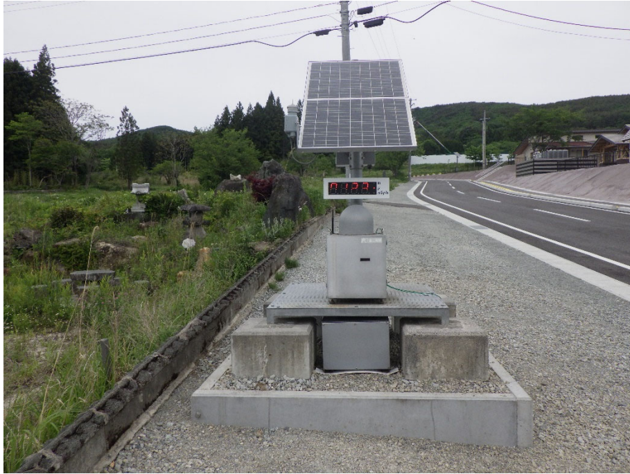
図2-10-13(2) 設置後の様子 (長泥コミュニティーセンター(飯舘村)：2023年5月23日撮影)
