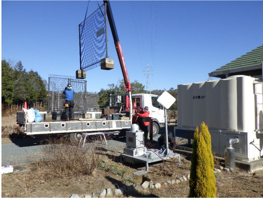
図2-10-11(2) 撤去作業の様子 (いわき市海竜の里センター(いわき市)：2024年1月15日撮影)
