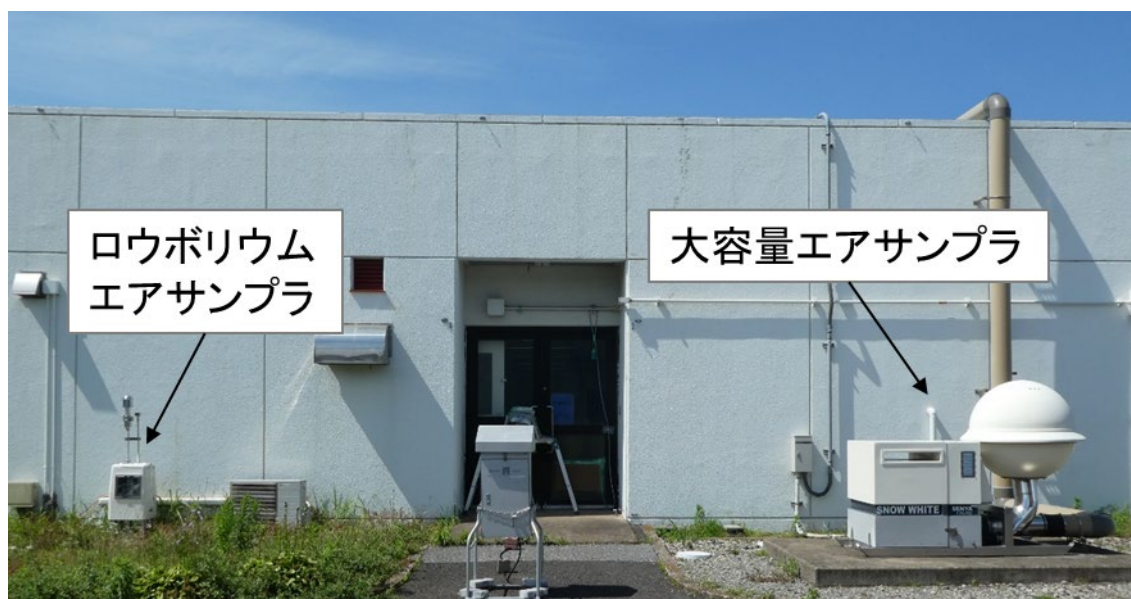
図 2-2-11 ロウボリウムエアサンプラと大容量エアサンプラ (SW) の設置状況
