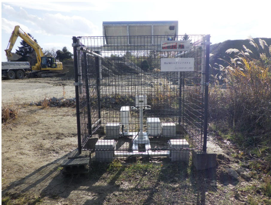
図 2-10-15(2) 更新後の可搬型モニタリングポスト (養護老人ホーム「東風荘」(富岡町) : 2023 年 12 月 5 日撮影)
