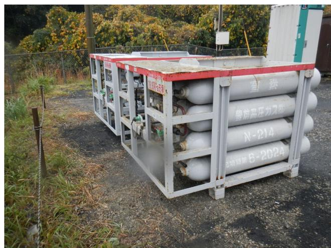
図8 ボンベカードル（19.6 MPa 200m<sup>3</sup>/一組×2）
