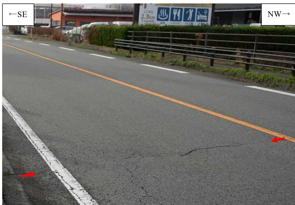
図 2.4.3 位相不連続ライン付近の左横ずれ変状
