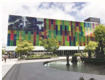
図 1 カラフルな外観のモントリオール国際会議場
