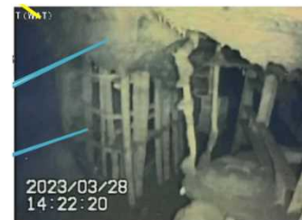
1号機ペDESTAL 開口部付近の状況
