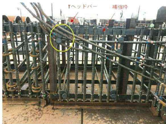
モックアップ試験 (水平鉄筋の変形状況)
