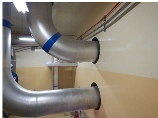
図3 貫通孔の隙間の例
