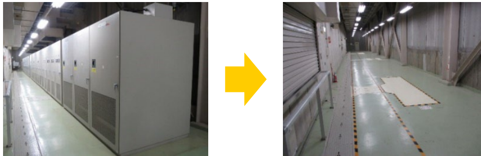
DOP-1高周波電源設備の解体
