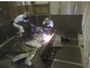
機器・架台の撤去、解体
