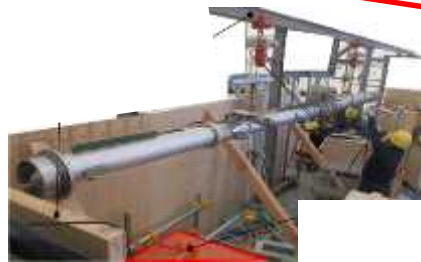
スプレー治具設置 ※X-53ペネに接続
