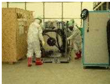
堆積物除去装置 （高圧水、AWJ）設置
