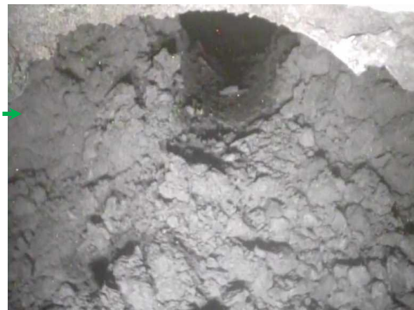
低圧水施工前 1月17日作業開始前
