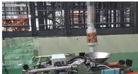
移送ホース (地下階接続作業)
