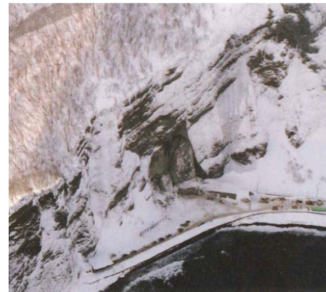
豊浜トンネル崩壊箇所全景
