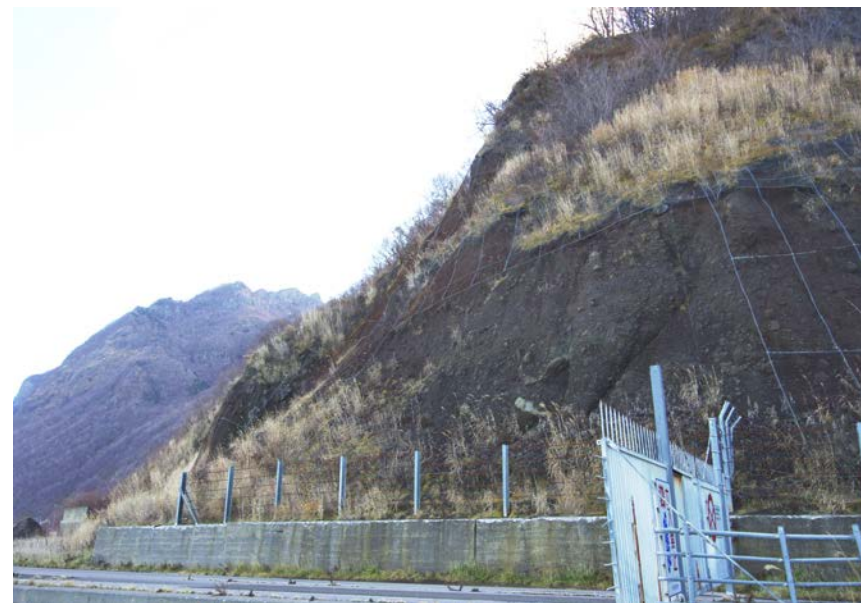
写真2:ブロック2の中央・先端部のカスペノ岬付近には、堅硬な火山礫凝灰岩が分布し、ブロックの地すべりを示唆する段差や破碎は認められない。
