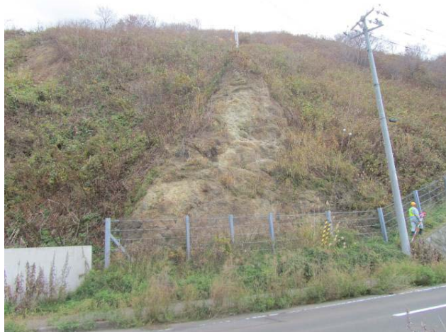
C07:ブロック10北側境界付近の神恵内層の変質安山岩。
