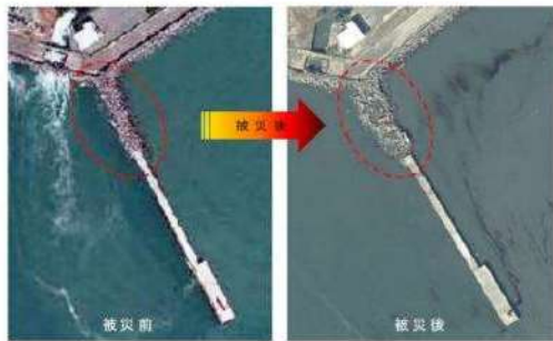
外港地区 北防波堤 (平成28年2月16日、3月12日撮影) 調査プロット 飛散 (100m)
