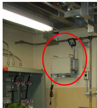
図2：蓄電池内蔵型照明取り付けイメージ図
