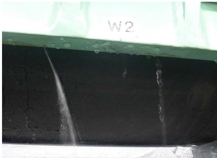
図 2 - 38 試験時の耐震ジョイントからの漏水状況(Y=200mm , X=100mm)
