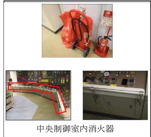
図 1-1 中央制御室における消火器及び手摺の状況
