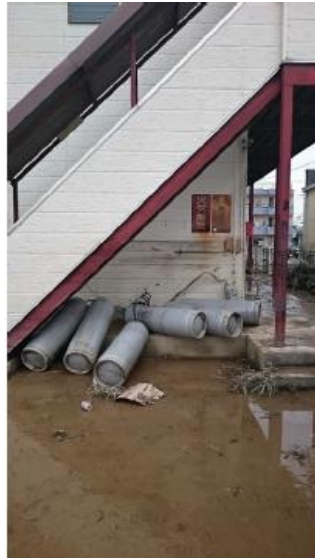
東日本豪雨(常総市の水害)でのLPガスボンベの被災状況の一例 *3
