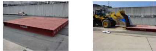
第6図 段差復旧状況
