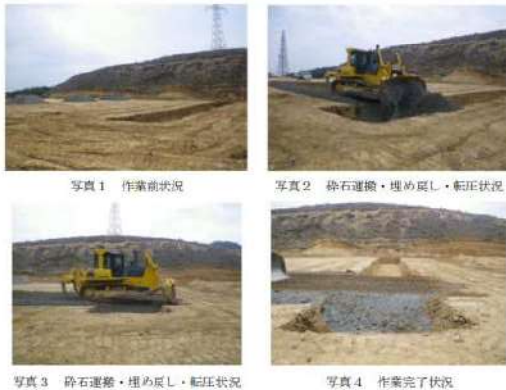
第2図 段差解消作業実証試験の状況
