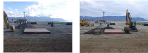
第10図 段差復旧状況
