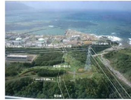
第2.2.3.4図 ②交差・近接箇所の現地状況 (1/3)
