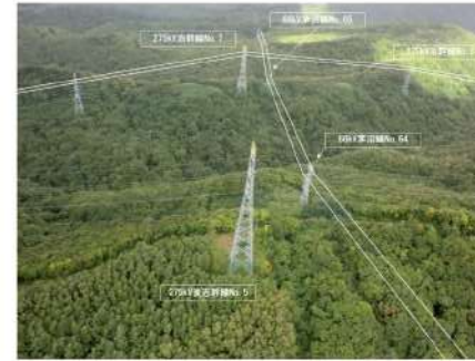
第2.2.3.5図 ③交差箇所の現地状況 (1/3)
