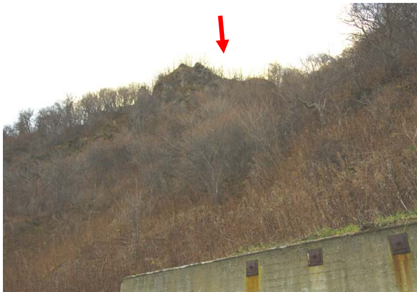
写真1:ブロック2及びブロック4の境界付近には、堅硬な火山礫凝灰岩が分布し、ブロックの地すべりを示唆する段差や破碎は認められない。
