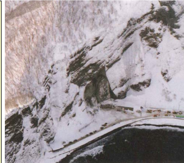
豊浜トンネル崩壊箇所全景
