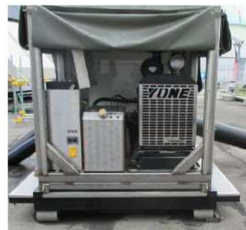
泡混合設備設置 (屋外)
