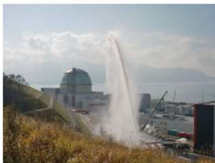
第2図 直線状放射による放水状況
