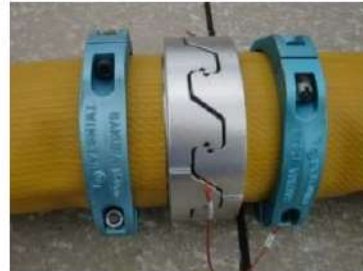
可搬型ホース（150A）接続後
