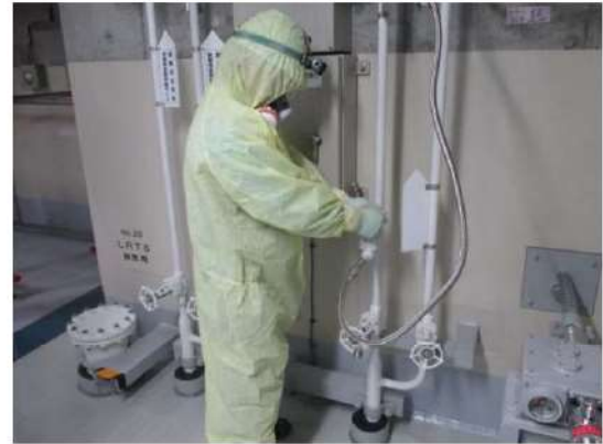
(制御用空気供給弁閉操作イメージ)
