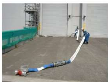
可搬型ホース敷設 （屋外）
