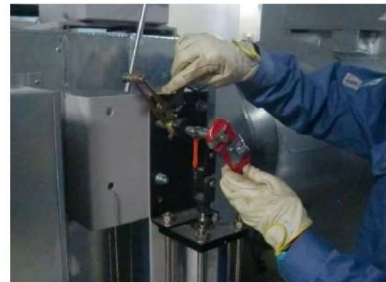
(空気作動ダンパ閉作業イメージ)
