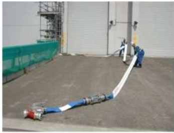
可搬型ホース敷設 (屋外)
