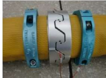
可搬型ホース(150A) 接続後
