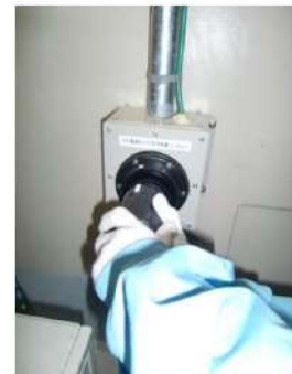
電源ケーブル接続
