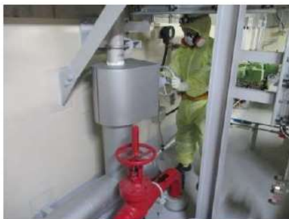
可搬型大型送水ポンプ車による原子炉格納容器下部への注水系統構成 （運転員（現場）B） （原子炉補助建屋 T. P. 10. 3m）
