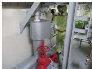
可搬型大型送水ポンプ車による原子炉格納容器内へのスプレイ系統構成
