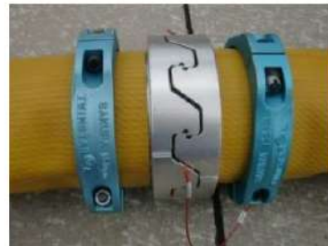
可搬型ホース(150A)接続後
