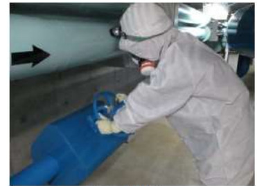
通水操作 (周辺補機棟 T. P. 2. 3m)
