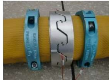
可搬型ホース (150A) 接続後
