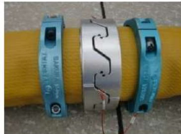
可搬型ホース（150A）接続後
