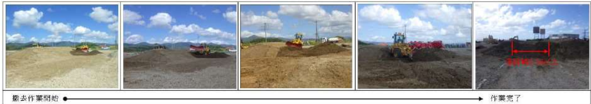
第5図 土砂撤去状況写真
