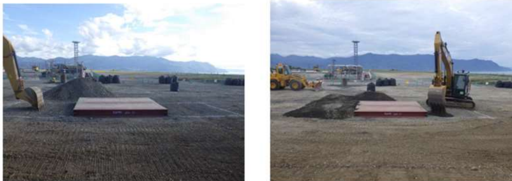
第10図 段差復旧状況
