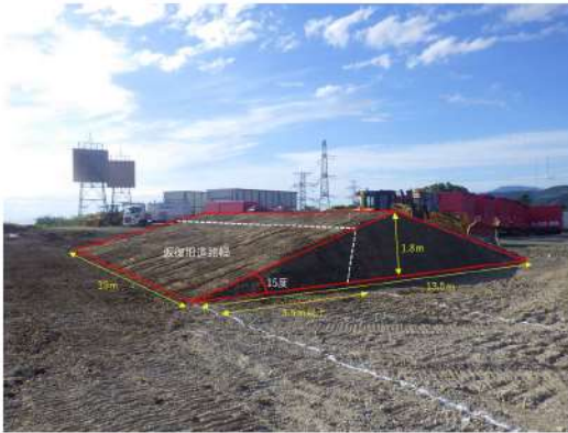
第3図 斜面崩壊後を模擬した土砂
