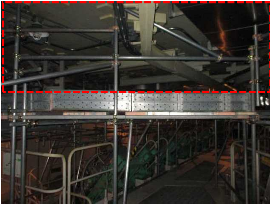
格納容器上部に火災防護対象機器等が設置されていないことを確認
