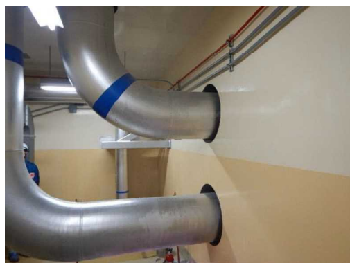
図3 貫通孔の隙間の例
