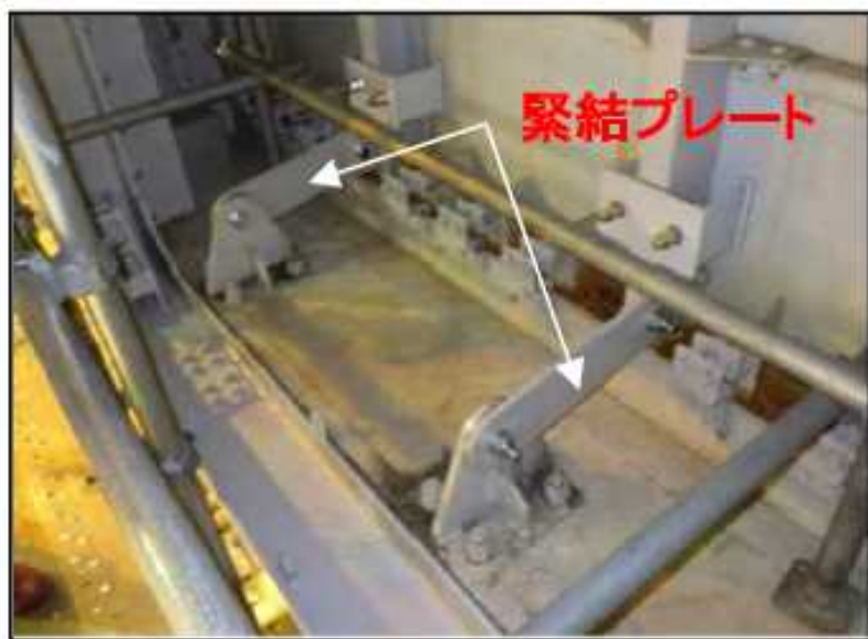
閉止パネル部（現状）
