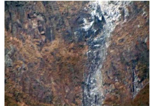
写真3: (写真2の拡大) 柱状節理の発達した堅硬な溶岩が露岩し、滑落崖等の地すべりを示唆する状況は認められない。
