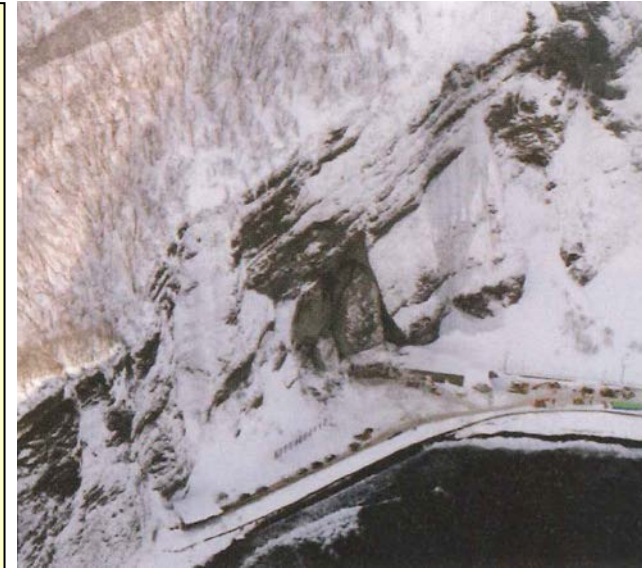
豊浜トンネル崩壊箇所全景
