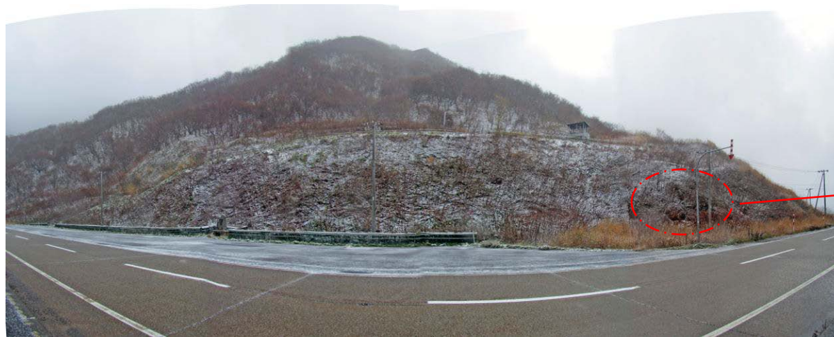
C03:ブロック3の平坦面, 部分的に新鮮な神恵内層の自破碎溶岩が認められる。
