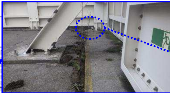
1号機 放水槽防潮壁 (内側)
