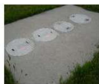
マンホール蓋
