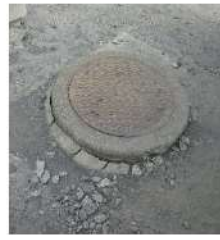
マンホール蓋
