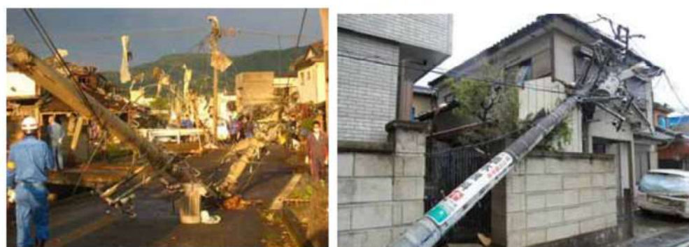
(電柱の折損, 傾斜)
