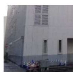
外壁 (セメント板)
