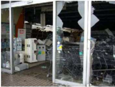
エントランスの窓ガラスの破損
