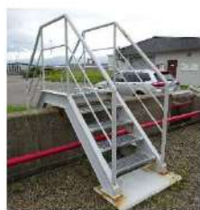
階段（H鋼製）
