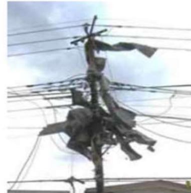
飛散した折板屋根の状況
