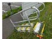
階段（単管パイプ製）
