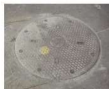
マンホール蓋
