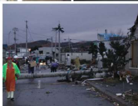
(電柱，道路標識の折損)
