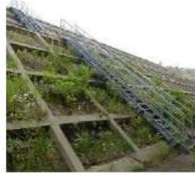
階段（H鋼製）
