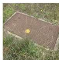
マンホール蓋
