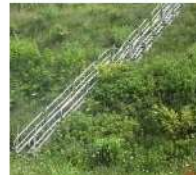
階段（単管パイプ製）
