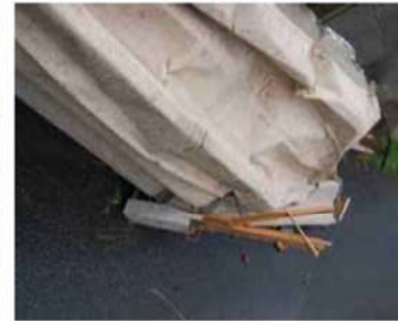
飛散した折板屋根の状況
