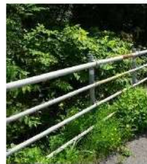
ガードパイプ
