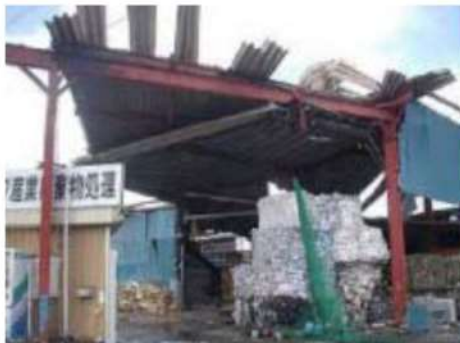
折板の損傷
