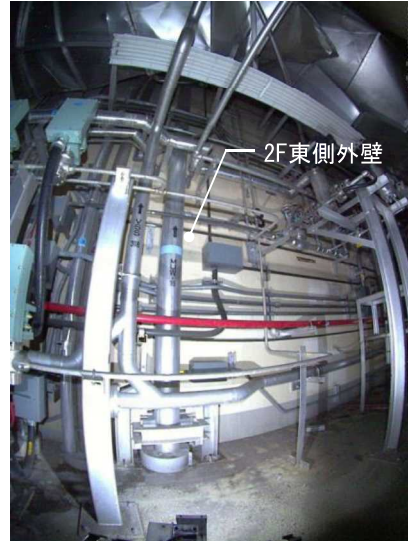
④2F東側外壁
