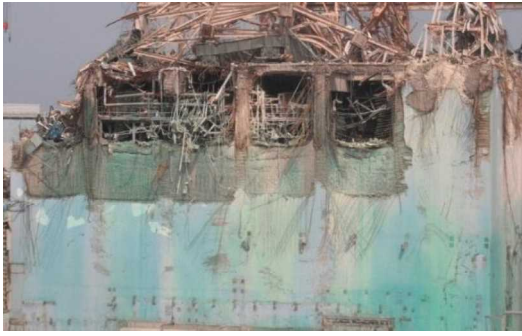
②東側壁面
