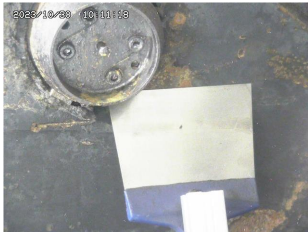
スクレーパ施工状況
