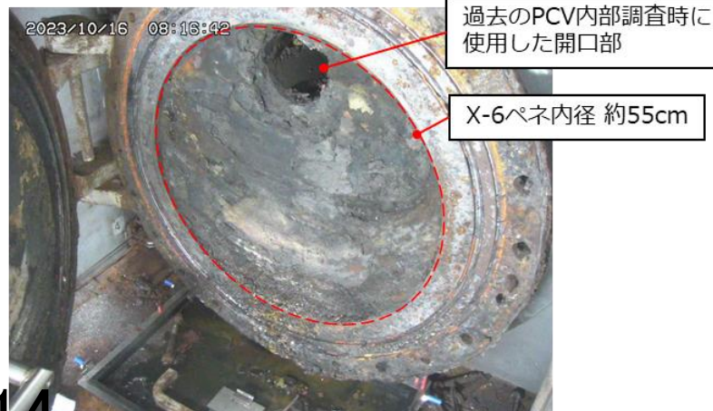
X-6ペネハッチ開放後(約90度) ※ペネを正面から見た状況
