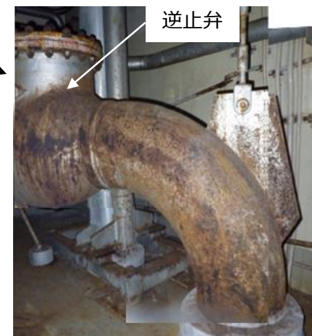
既設CUW配管
