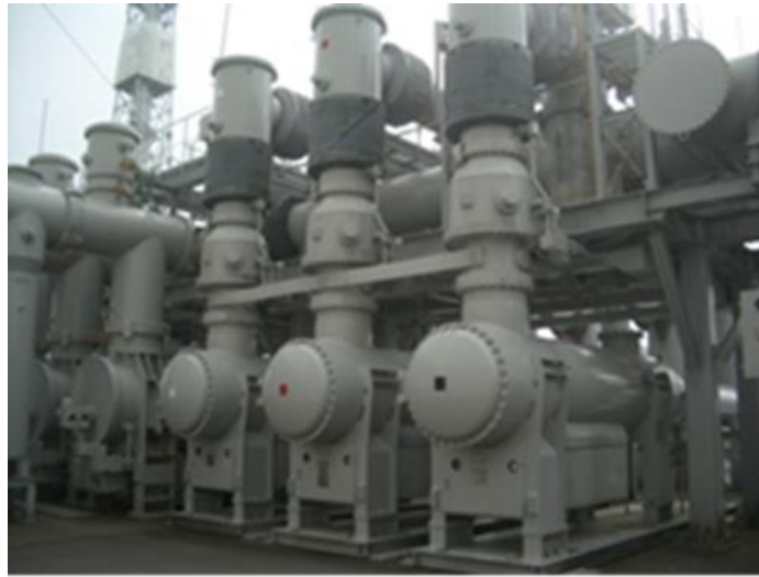
(ガス絶縁開閉装置イメージ)
