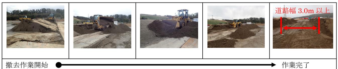
図 12-2 土砂撤去状況
